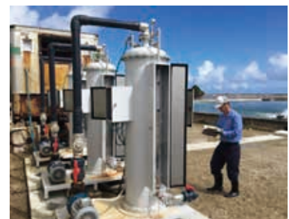
養殖場に設置された、高濃度酸素溶解装置
