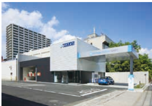
建設実績：巴商会 新砂水素ステーション
